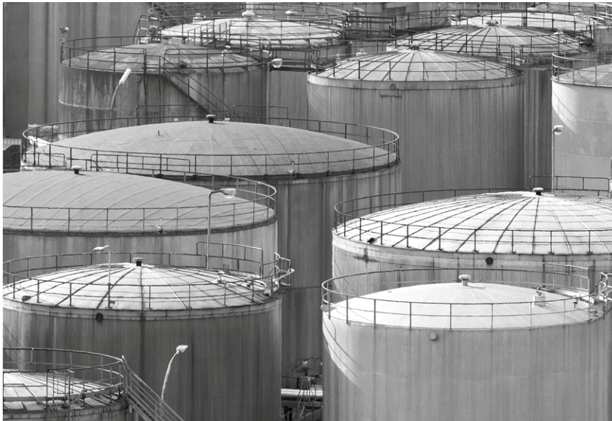
HAMBURG Zwischen- und Endprodukte lagern in der Tankfarm am Standort.
